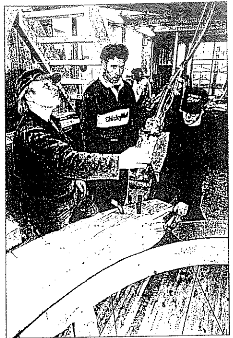
Byggnadssnickarna Markku Nyrönen, Peter Fröhler och Patrick Olovsson arbetar med att sätta ihop spanten.
